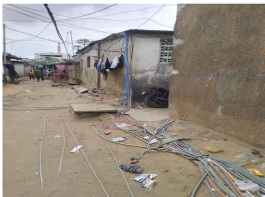
**Photo A :** Installation informelle de câbles électriques à Gobelet. Cela met en évidence le recours à des solutions non réglementaires.
