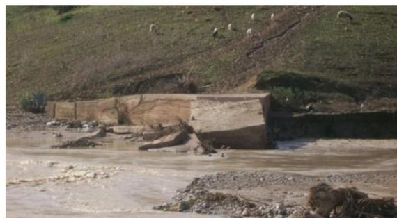
**Photo 1 :** Effondrement d'un pont sur l'Oued.
