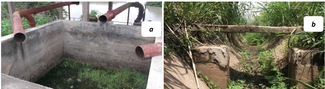
Planche 2: Retenue d'eau et chenal de drainage d'eau sur le périmètre irrigué de Dévé Prise de vue: MIASSOUNA, octobre 2013
